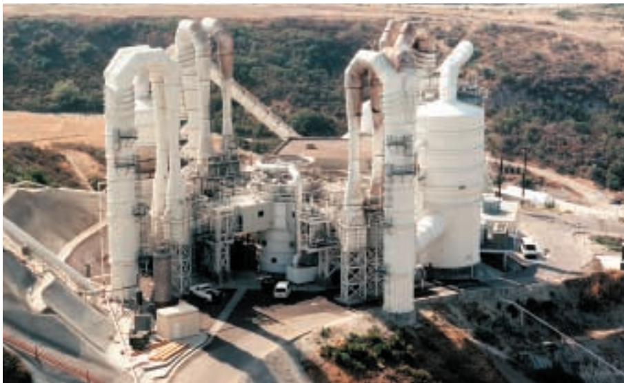
Der Standort des TRW Laserprojekts für die Strategische Verteidigungsinitiative (SDI) in Kalifornien ist eine der größten Vakuump- und Lüftungsstationen der Welt. Die von Croll-Reynolds hergestellten Ejektoren simulieren die Atmosphäre im Weltraum für Versuche mit dem Wasserstoff/Fluor Laser. Die durch die Erzeugung des Lasers entstehenden Gase werden von einer speziell angefertigten Packturm-Schrubbürste entfernt.
