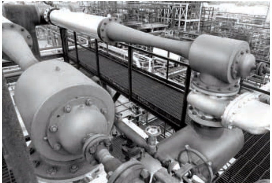
Dans les industries pétrochimiques et chimiques, des thermocompresseurs de Croll-Reynolds recyclent la vapeur usagée et réduisent de 30 % ou plus la consommation d'énergie.
